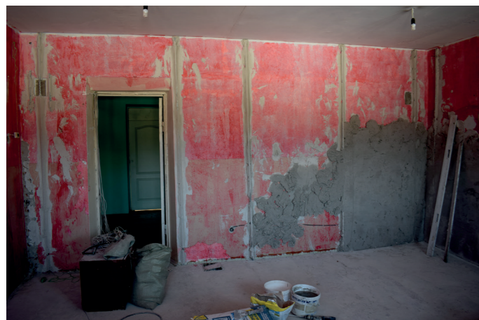
Помещение учебного класса до ремонта
